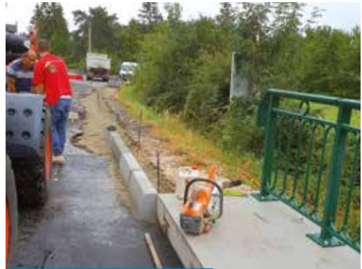
TRAVAUX PONTS DU COSSON 2018
