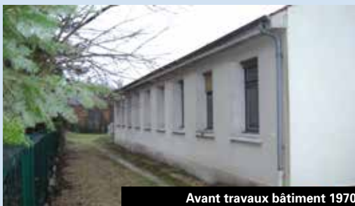
Avant travaux bâtiment 1970
