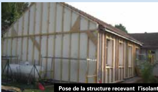
Pose de la structure recevant l'isolant
