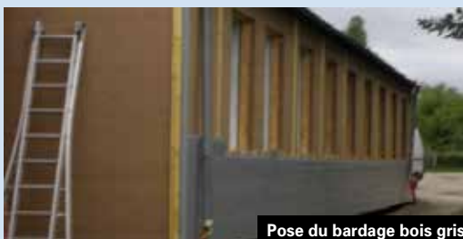
Pose du bardage bois gris
