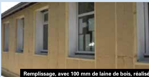
Remplissage, avec 100 mm de laine de bois, réalisé
