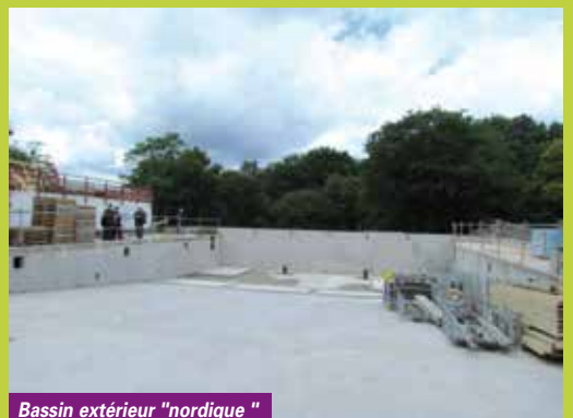
Bassin extérieur "nordique"
