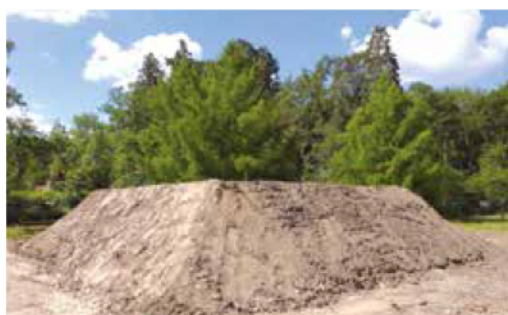
Juin 2019 : Fondations et construction de la plateforme du local technique
