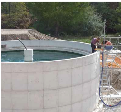
Septembre 2019 : Construction et test d'étanchéité du clarificateur
