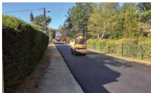
Septembre 2019 : Rénovation de la voirie
