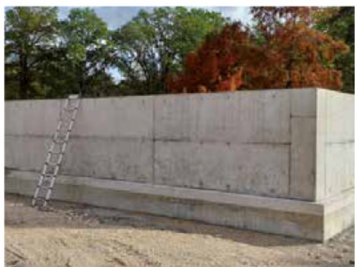
Novembre 2019 : Construction des lits rhizophytes
