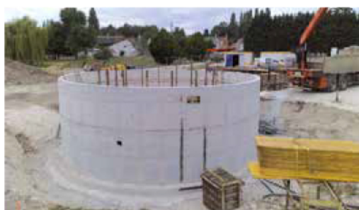
Juillet 2019 : Construction de l'aérateur
