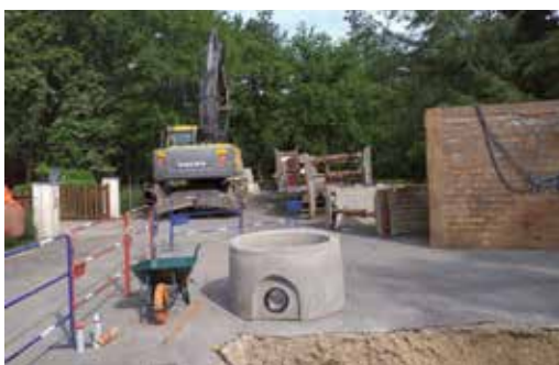
Juin 2019 : Début des travaux
